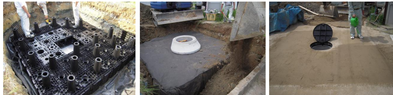
① 地下貯水槽組立
