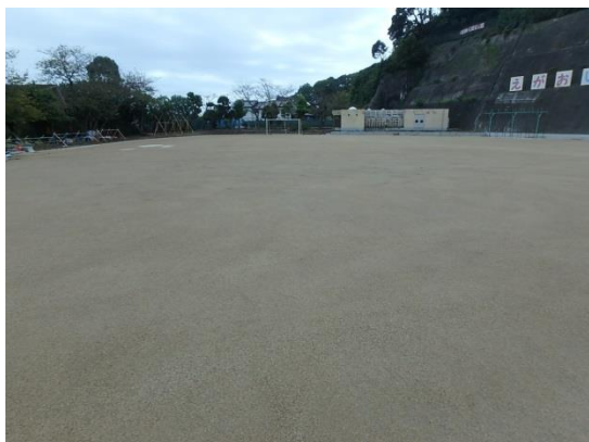
町立小学校野外運動場整備工事 3500 m 2 施 工：ヘルシースポーツ建設株式会社
